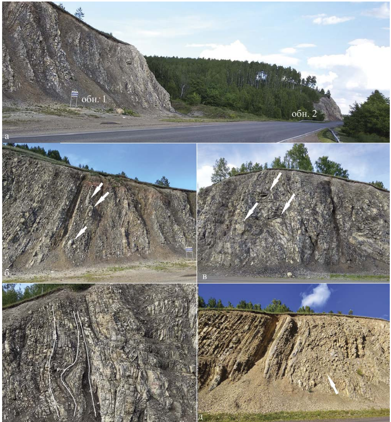
Рис. 3. Подводно-оползневые структуры в отложениях янгантауской свиты в разрезе Ахуново. Дорожные выемки автодороги Месягутово – Малояз в районе д. Ахуново
