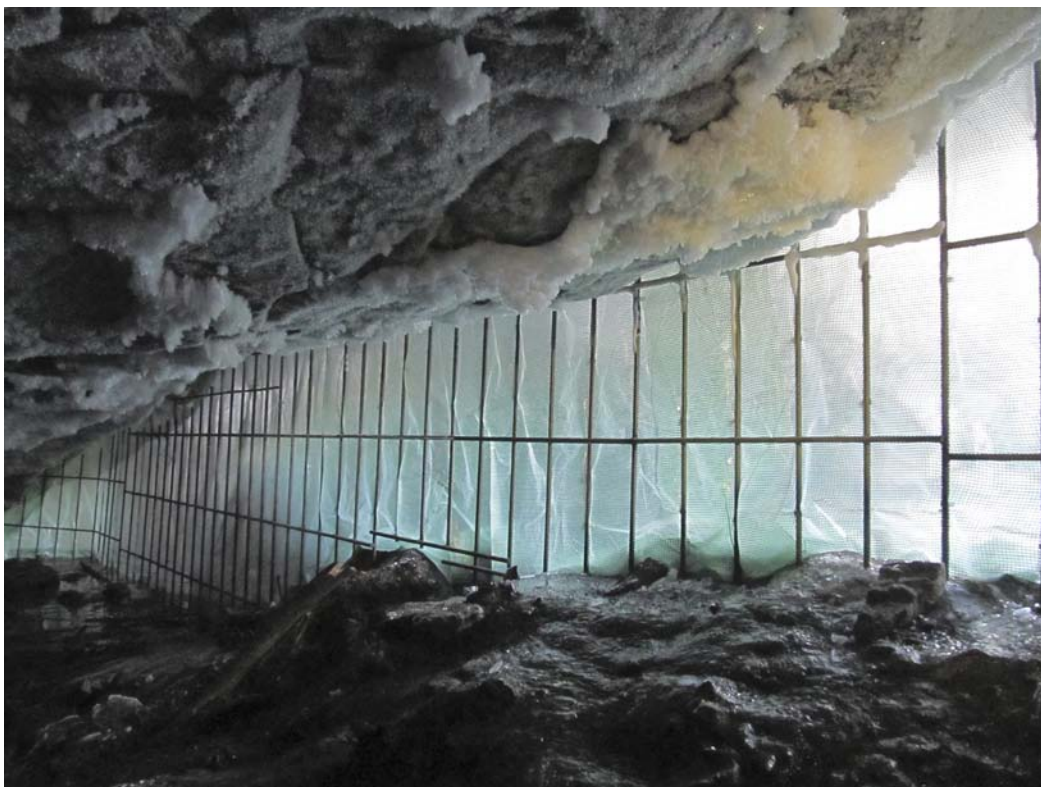
Рис. 4. Решетка и экран в устье входа в Аскынскую ледяную пещеру. Фото Ш.И. Муслухова Fig. 4. Lattice and screen at the mouth of the entrance to the Askyn ice Cave. Photo by Sh.I. Muslukhov
