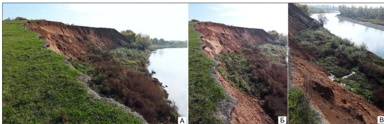
Рис. 7. Оползень на ЮЮЗ окраине с. Кумурлы Архангельского района в 2023 г.
